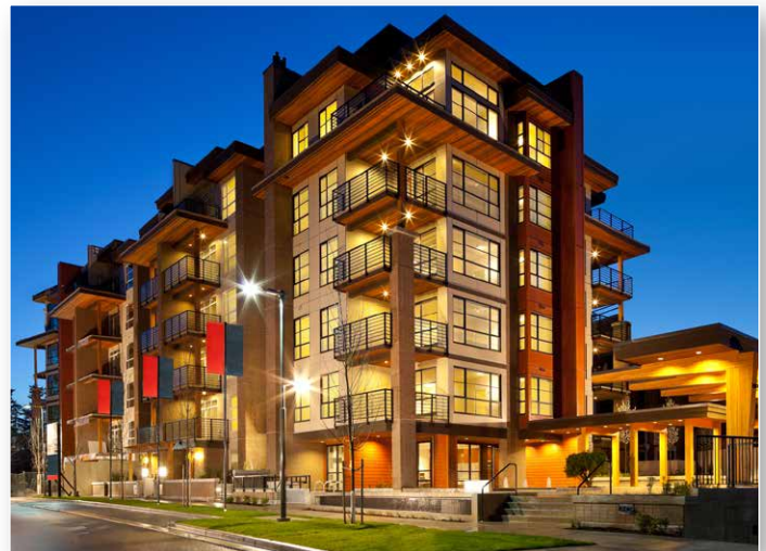
Immeuble Sail, Westbrook, Université de la Colombie-Britannique, Vancouver (C.-B.). Photo par Raef Grohne, utilisée avec l'autorisation de Adera Development Corporation.
