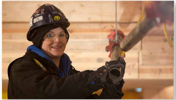
Installation de canalisations d'eau au Wood Innovation and Design Centre, à Prince George (C.-B.). Selon un nouveau rapport, la sécurité-incendie des bâtiments dépend directement des systèmes de protection contre les incendies, comme les gicleurs, plutôt que des matériaux utilisés lors de la construction. Photo utilisée avec l'autorisation de naturally:wood.
